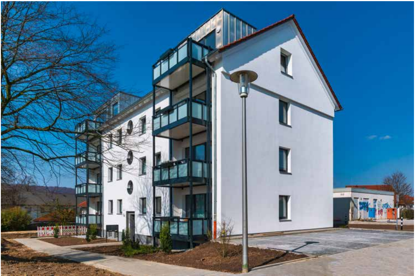
Modernisierungsmaßnahme Schöne Aussicht 5 – Foto: Gábor Wallrabenstein
