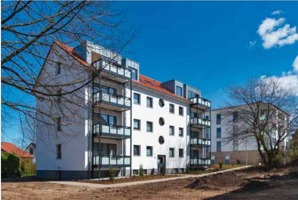
Modernisierungsmaßnahme Schöne Aussicht 5 – Foto: Gábor Wallrabenstein
