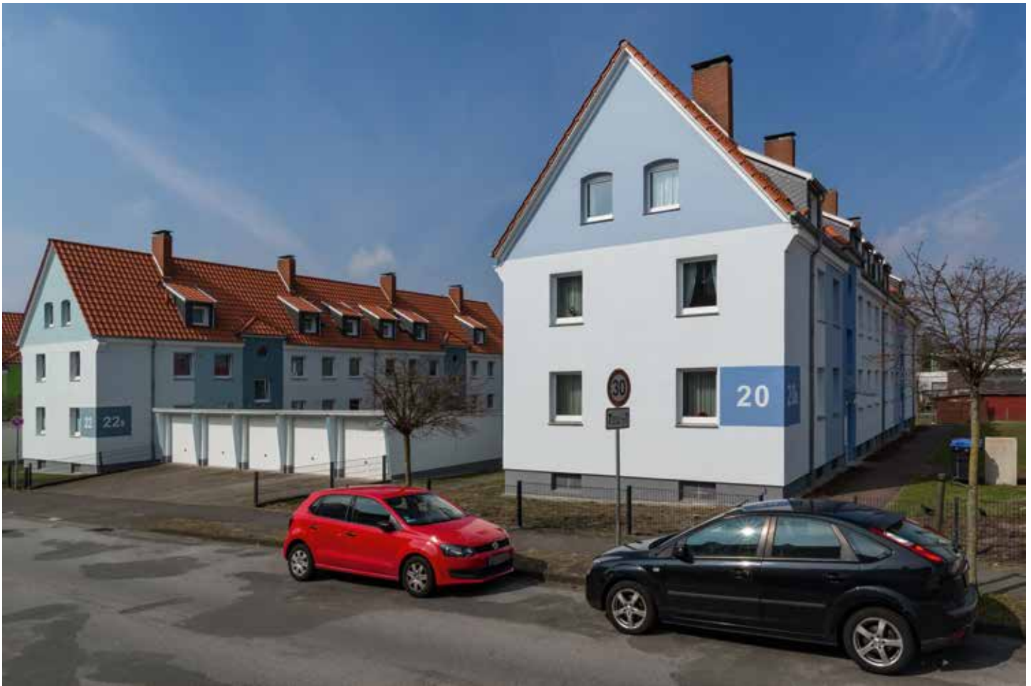
Modernisierungsmaßnahme Westfalenstr. 20, 20 A u. 22, 22 A – Foto: Gábor Wallrabenstein
