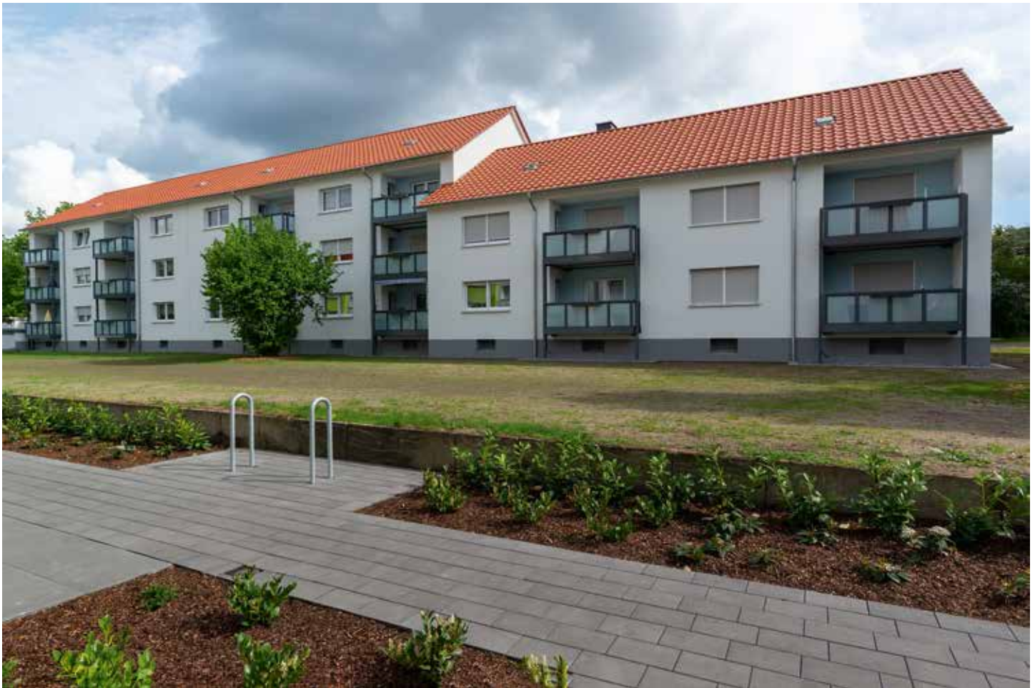
Modernisierungsmaßnahme Stadtring 93 A - 97 B – Foto: Gábor Wallrabenstein
