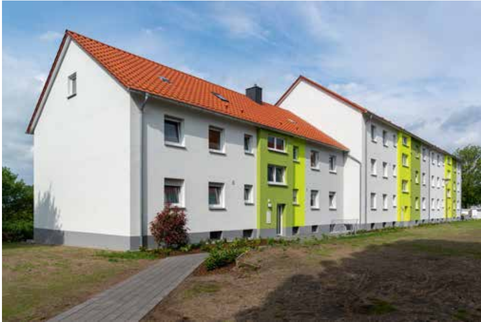
Modernisierungsmaßnahme Stadtring 93 A - 97 B – Foto: Gábor Wallrabenstein
