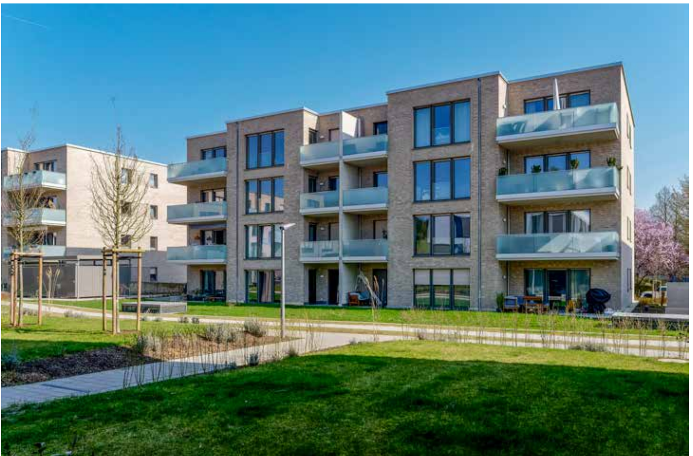
Neubaumaßnahme Grünewaldstraße, Dornberg - Foto: Gábor Wallrabenstein
