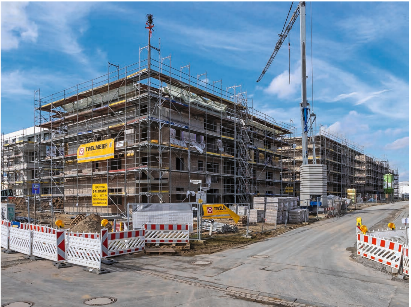
Neubaumaßnahme Grünewaldstraße, Dornberg – Foto: Gábor Wallrabenstein
