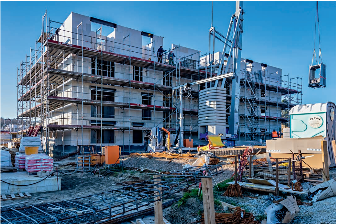
Neubaumaßnahme Grünewaldstraße, Dornberg – Foto: Gábor Wallrabenstein
